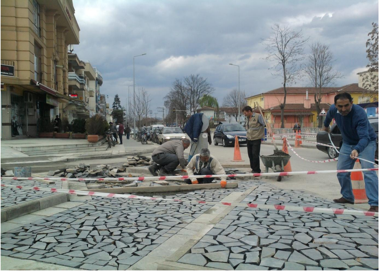
Kuyumcuzade Bulvarı Eski Düzce Lisesi Kavşak Yapım
