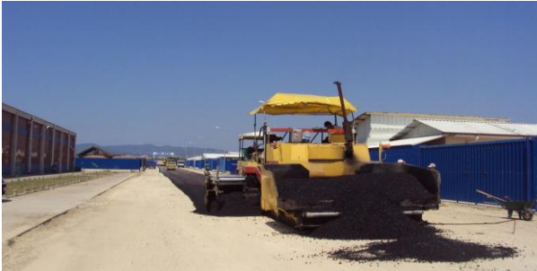
Hurdacılar Sitesi asfalt serme çalışması
