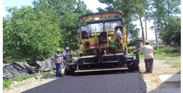
Arapçiftliği Mah. asfalt serme çalışması
