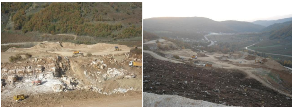
Düzce Katı Atık Bertaraf Tesisi 1.Etap İnşaatı çalışmaları
