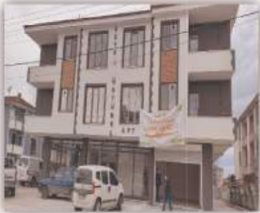
%95 Hakediş seviye kontrolü yapılmıştır.
