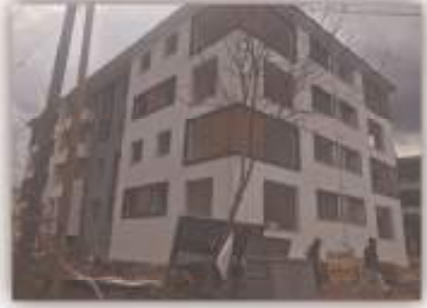
%80 Hakediş seviye kontrolü yapılmıştır.
