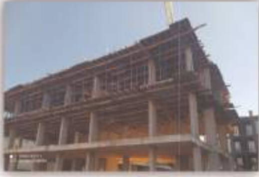
% 60 Hakediş seviye kontrolü yapılmıştır.
