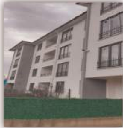
%100 Yapı kullanım izin belgesi seviye kontrolü yapılmıştır.
