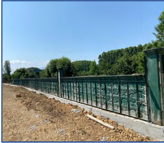
Mezarlık Etrafı Çelik Kalıp ile Duvar Çalışması
