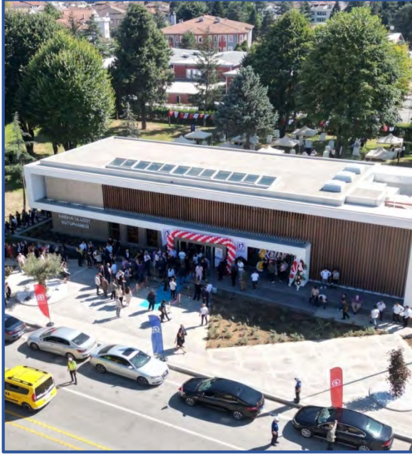
Sabiha Ulusoy Kütüphanesi nin doğasına ve mimarisine uygun şekilde kaldırım ve çevre düzenlemesi yapıldı
