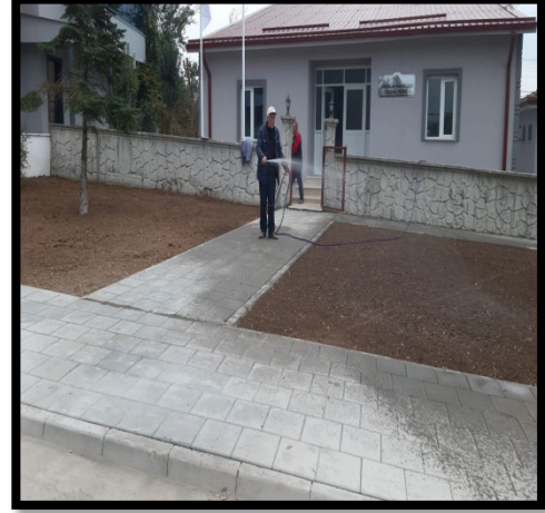
Çakırlar Mahalle Konağı Çevre Düzenleme
