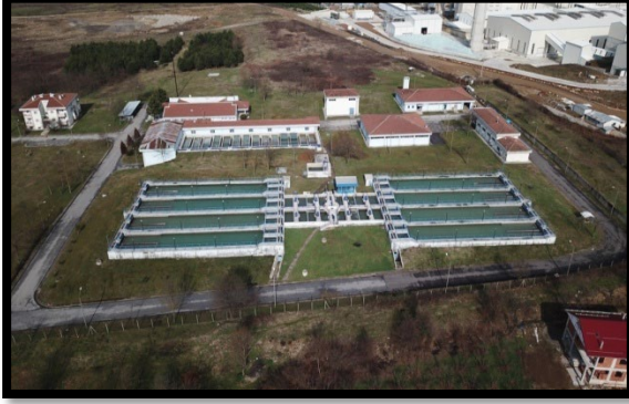
İçme Suyu Arıtma Tesisi
