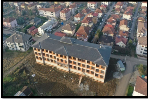
Azmimilli Mahallesi Okul Yapımı Projesi
