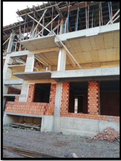
%60 Hakediş seviyesi kontrolü yapılmıştır.
