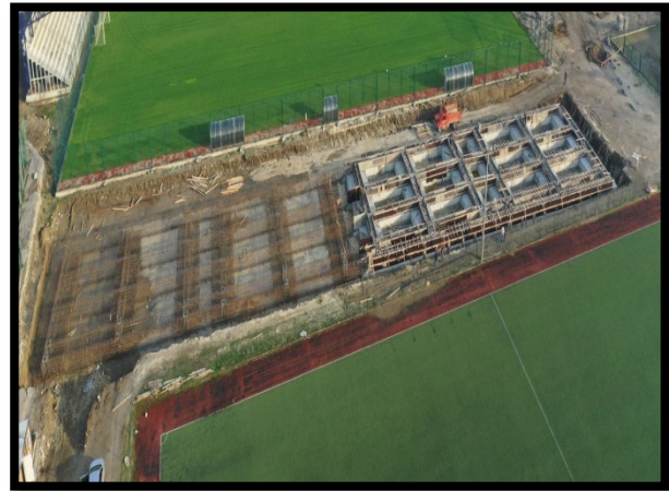
Şıralık Spor Kompleksi 2. ETAP
