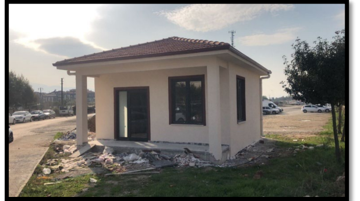
7 Mahalleye Yeni Muhtarlık Yapımı Projesi
