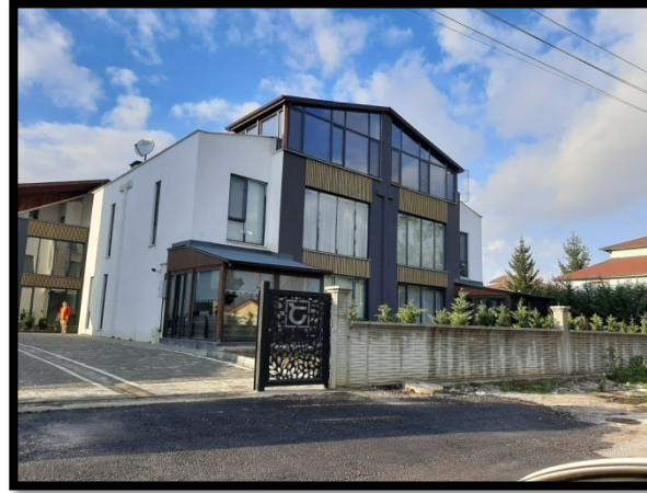
%100 Hakediş seviyesi kontrolü yapılmıştır.
