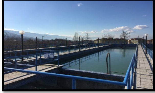
İçme Suyu Arıtma Tesisi Durultucu Havuzlar
