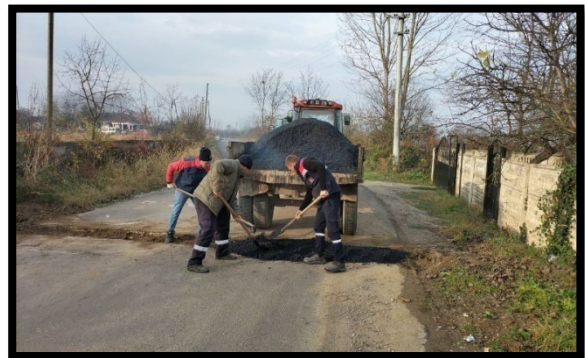
Asfalt Yama Çalışması
