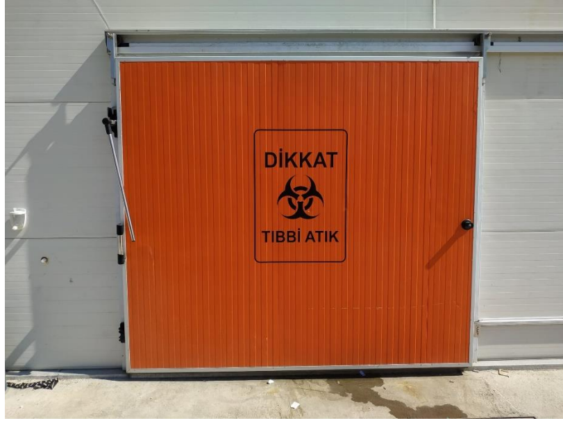
Fotoğraf 7: Geçici Depolama Alanı Giriş Kapısı
