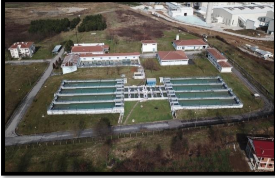
İçme Suyu Arıtma Tesisi
