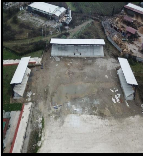
Şıralık Spor Kompleksi Çelik Tribün Yapım İşİ
