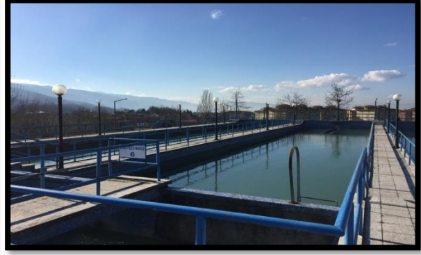
İçme Suyu Arıtma Tesisi Durultucu Havuzlar
