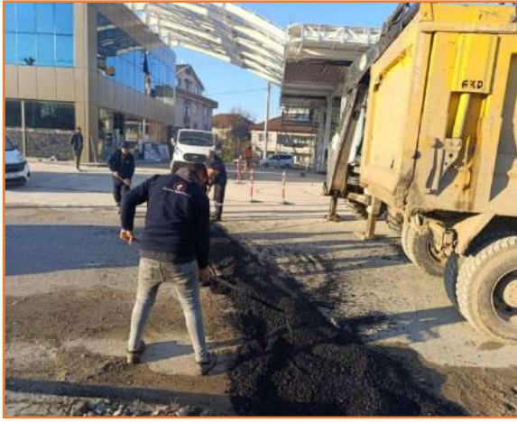
2024 yılı 12 aylık faaliyete göre merkez mahallelerde kullanılmak üzere 17.570 ton asfalt yama çalışması yapılmıştır.
